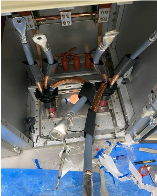
مراحل اتصال کابلشو به کابل به ترتیب از سمت راست به چپ
